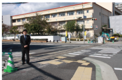
建設中の防潮鉄扉を見て参りました。対策の一つはすでに進んでいます。
